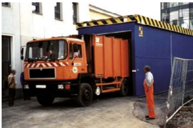
Lastenaufzug für LKW, Plattform 11.0 x 3.8 m, Nutzlast 16 t
