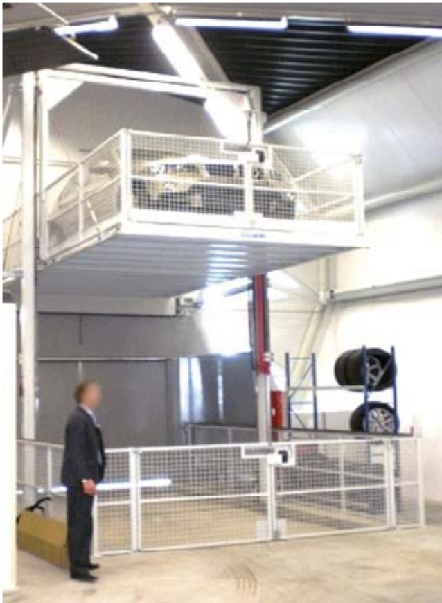
Autohebebühne als 2-Säulenheber, Nutzlast 2.5 t, Nutzhub 3.64 m
